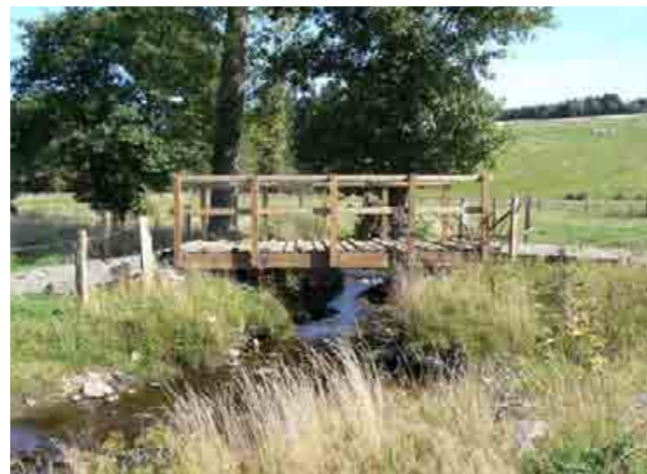
Errichten eines Viehübergangs. Installation d'un passage à bétail.
