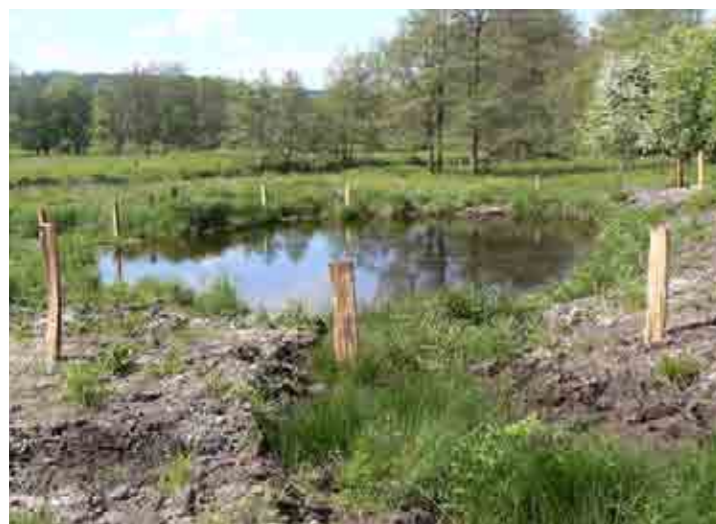
Création d'une mare avec installation d'une clôture. Anlegen eines Tümpels und Errichten eines Zaunes.
