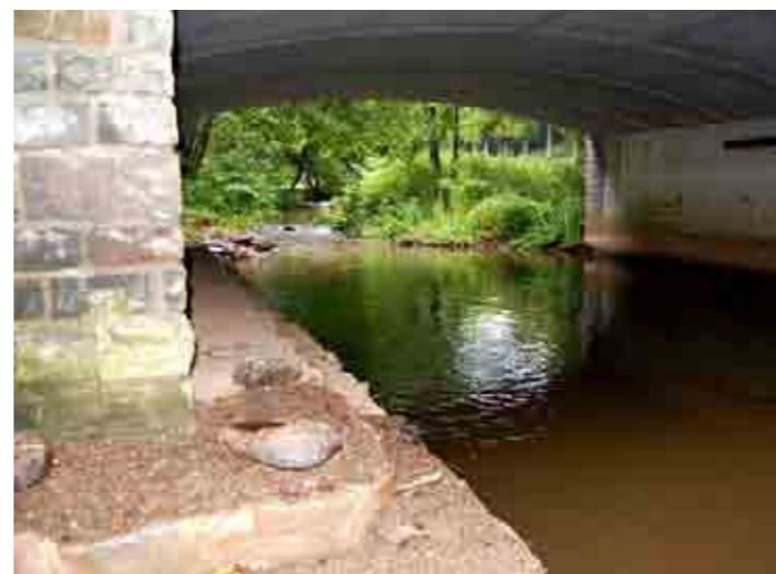
Construction d'un lutrodoc sur la Wark. Errichtung eines Otterdurchlasses an der Wark.
